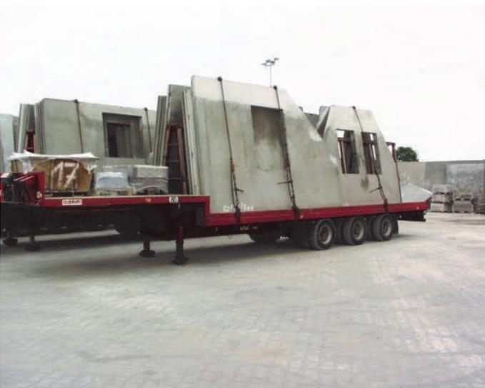
CONTIGA TINGLEV Elemente bieten Hausbauern aller Größenordnungen die Möglichkeit, in kurzer Zeit einen individuellen, preiswerten und wohngesunden Rohbau zu errichten. Aussparungen, Durchbrüche und Schlitzlöcher sind ebenso integriert wie Elektroerohre und -dosen, statisch notwendige Stürze, Stützen, Ringbalken und Ankerplatten.
