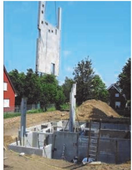
Geschossübergreifende Wandbauteile werden gedreht und hochkant eingesetzt.
