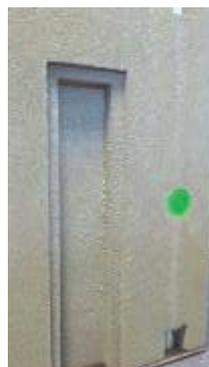
Ebenso können die Wände mit Aussparungen für die Sanitärinstallation geliefert werden.
