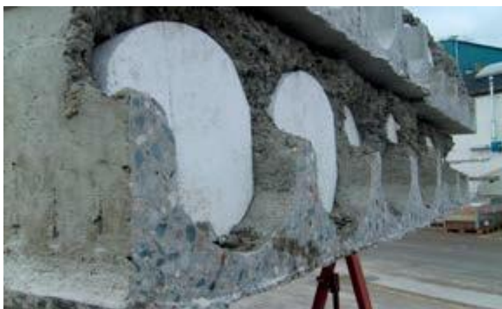
Foto 1: Udsparring i overside/grøft ved elementende
