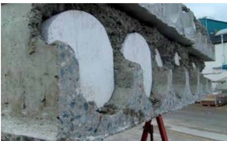
Foto 1: Udsparring i overside/grøft ved elementende
